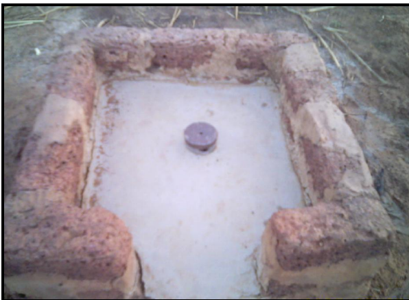
Photo 4 : Bassin de stockage d'eau : lawar
