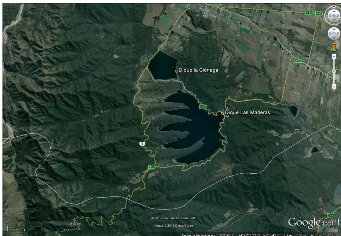
Figura 1-2: Área de los diques en la cuenca media
