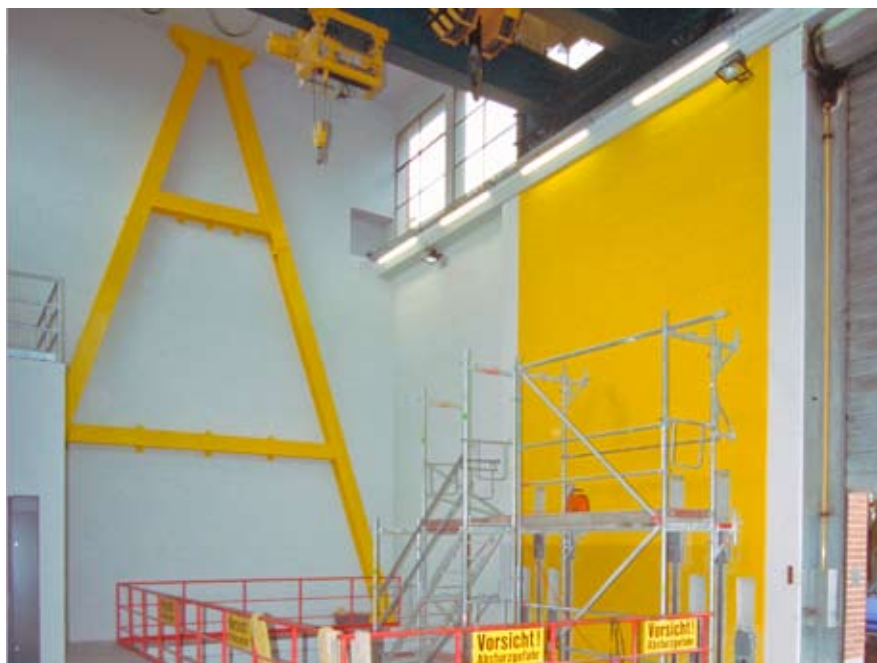
Nouveau contreventement dans la façade ouest et nouvelle paroi porteuse en béton armé dans la façade nord de la halle de montage.
