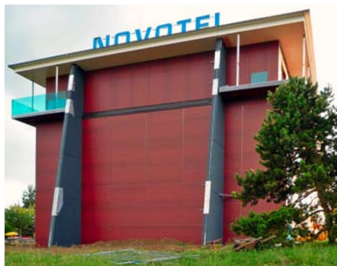
Façade d'extrémité sud, avec les deux nouvelles parois triangulaires en béton armé.
