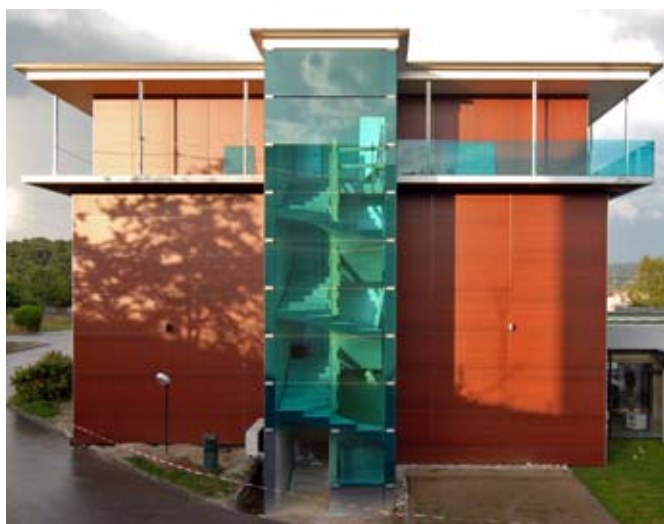
Façade d'extrémité nord, avec la nouvelle cage d'escalier en béton armé.
