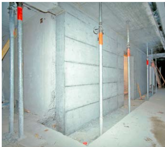
Nouvelle paroi couplée en béton armé au sous-sol.
