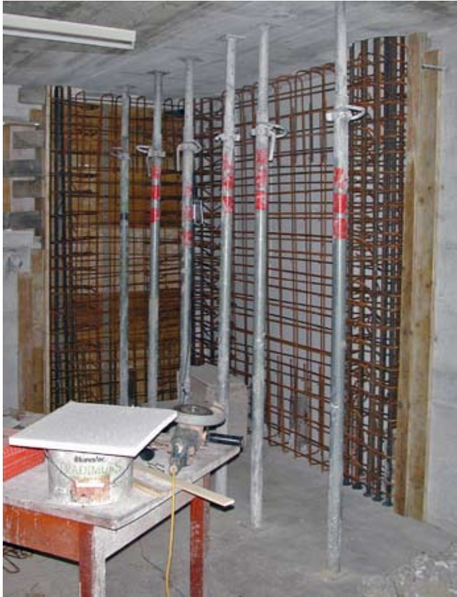
Armature d'une nouvelle paroi en béton armé au sous-sol.
