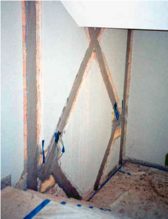
Renforcement des parois en maçonnerie avec des lamelles en fibres de carbone.
