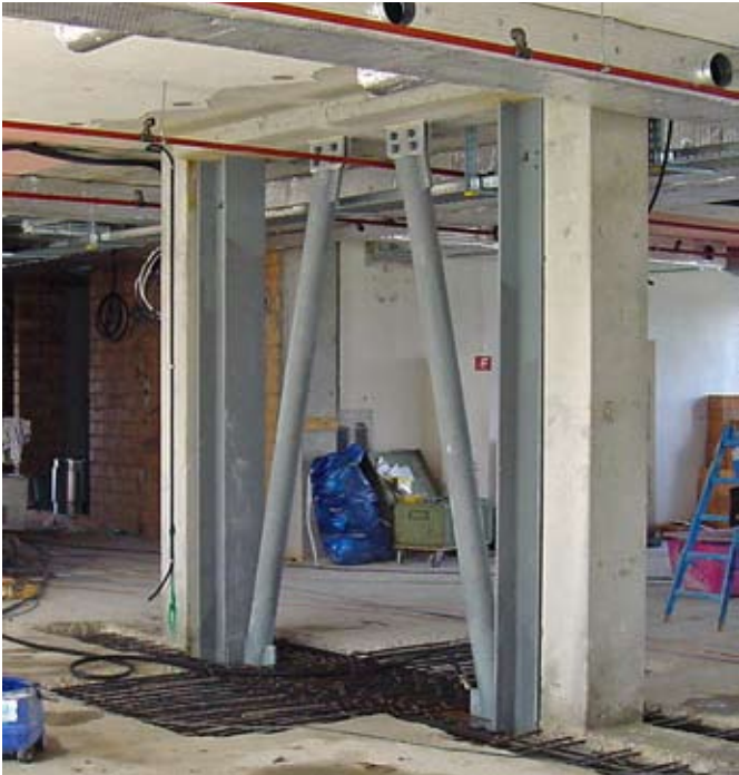
Nouveau cadre en acier de type excentré, placé entre deux colonnes en béton armé existantes.
