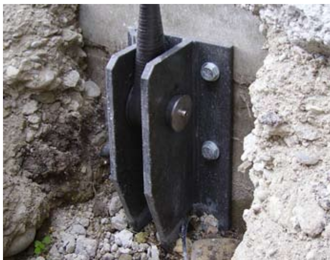
Ancrage inférieur des éléments précontraints en fibres de carbone contre la paroi de la cave.
