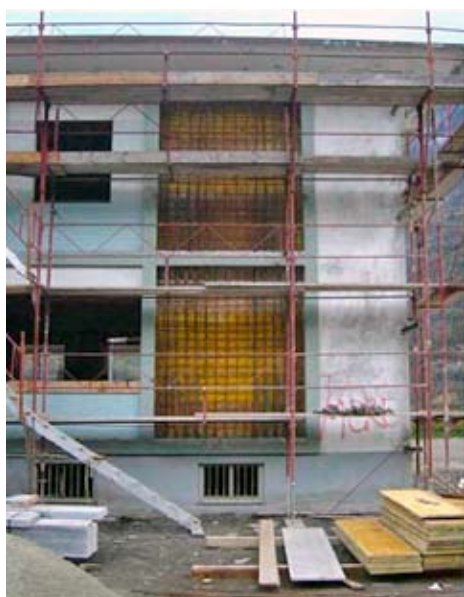
Armature d'une nouvelle paroi en béton armé.
