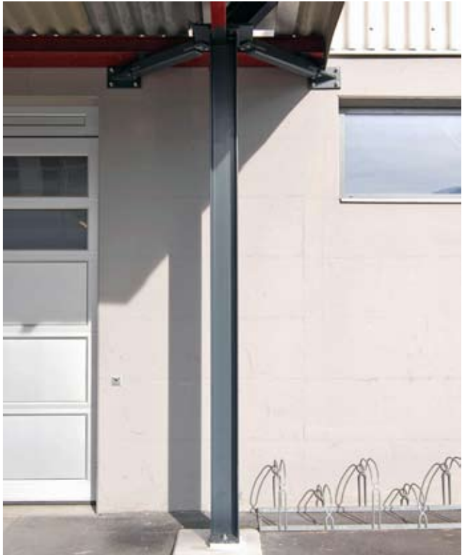
Colonne de bord du treillis arqué au niveau du sous-sol.
