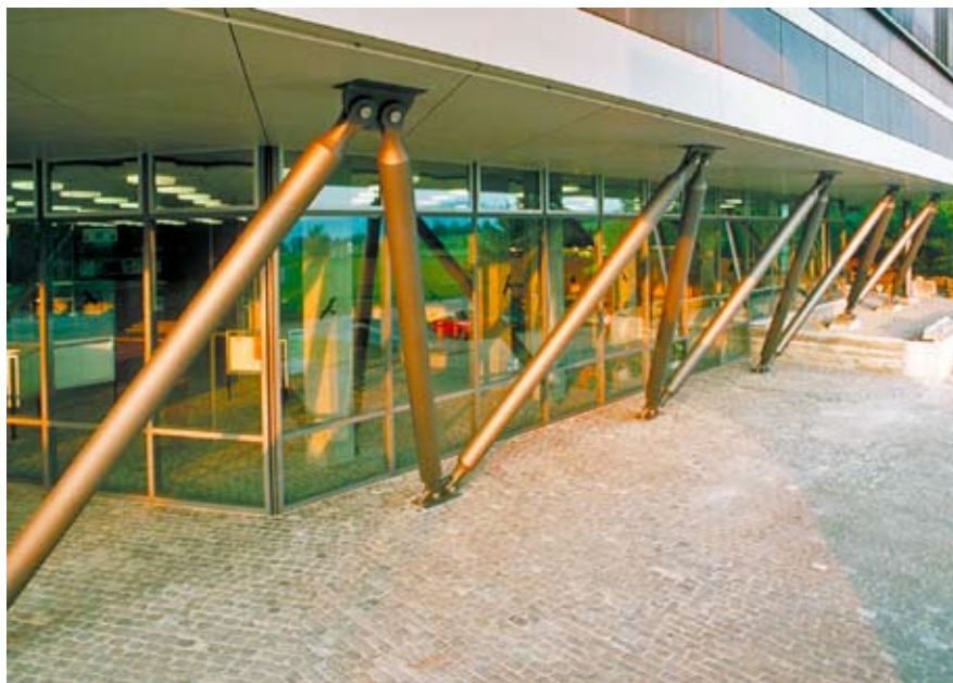
Nouveau treillis oblique formé de tubes en acier au rez-de-chaussée.
