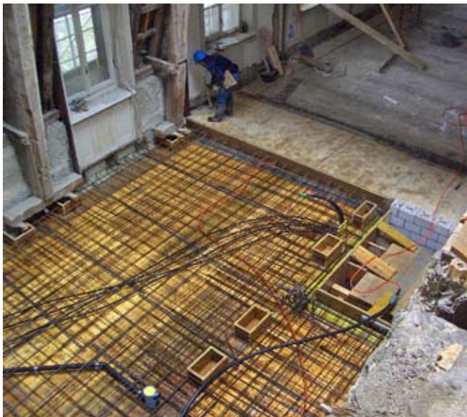
Plancher en béton dans la zone d’un nouveau noyau technique.
