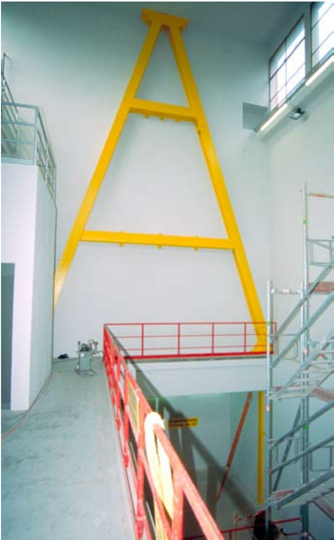
Nouveau treillis métallique en forme de A au rez-de chaussée de la façade ouest et nouvelles lamelles en acier au sous-sol.
