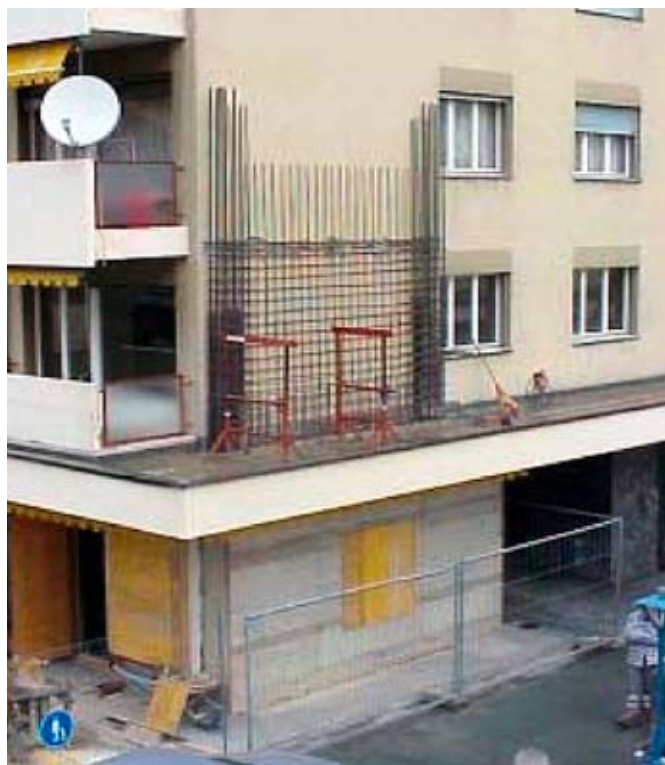
Nouvelle paroi porteuse en béton armé bétonnée contre la façade existante (Lateltin, 2003).
