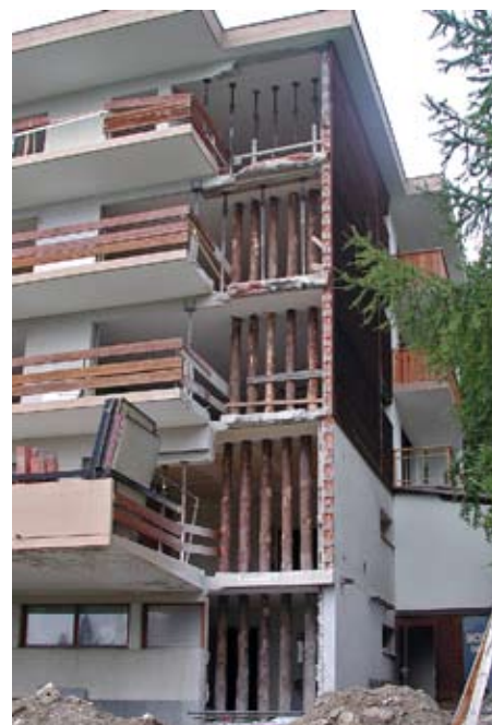
Transformation de l'angle sud-est.
