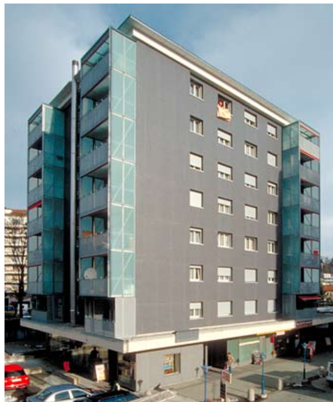
Vue de la nouvelle paroi en béton armé.
