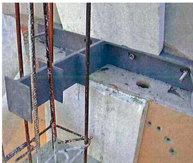
Élément d'acier en «T» servant à ancrer les nouvelles parois en béton armé dans les planchers existants.
