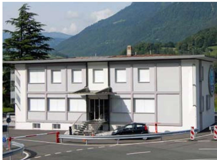
Vue des façade avant avec la nouvelle paroi en béton armé au niveau du cadre à l'extrême droite.
