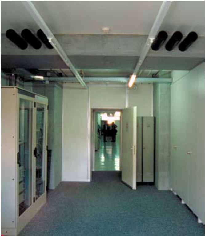
Vue de l’ancrage des six câbles précontraints à une poutre transversale reliant les deux nouvelles parois en béton armé en forme de «I» situées dans la nouvelle aile.
