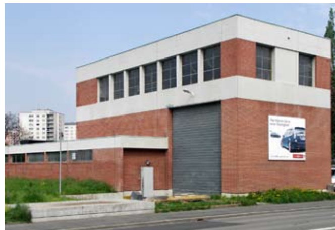
Vue extérieure de la halle de montage.
