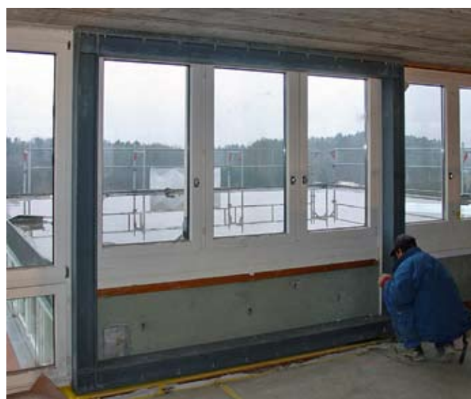
Contreventement de l'étage de toiture par un nouveau cadre en acier.
