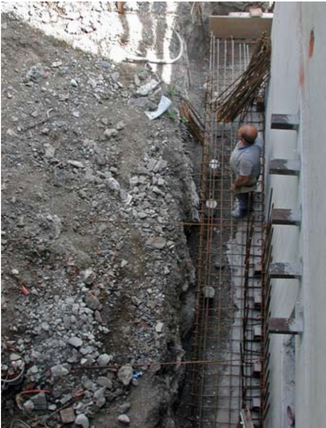
Fondation d'une des nouvelles parois en béton armé.
