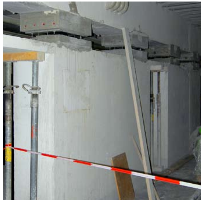
Insertion d'appuis glissants sous l'espace intérieur dépourvu de colonnes.
