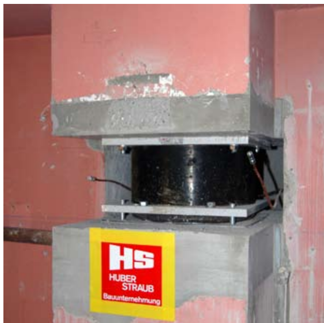
Insertion d'un appui sismique en caoutchouc sous une colonne au niveau de la paroi extérieure du sous-sol.
