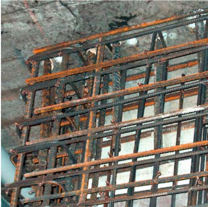
Armature de liaison entre les nouvelles parois en béton armé et les dalles existantes (Garcia-Vogel, 2005).
