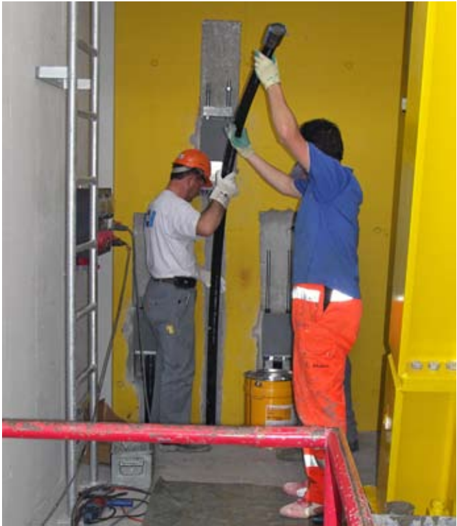
Insertion des lamelles en fibres de carbone pour ancrer les nouvelles parois en béton armé.
