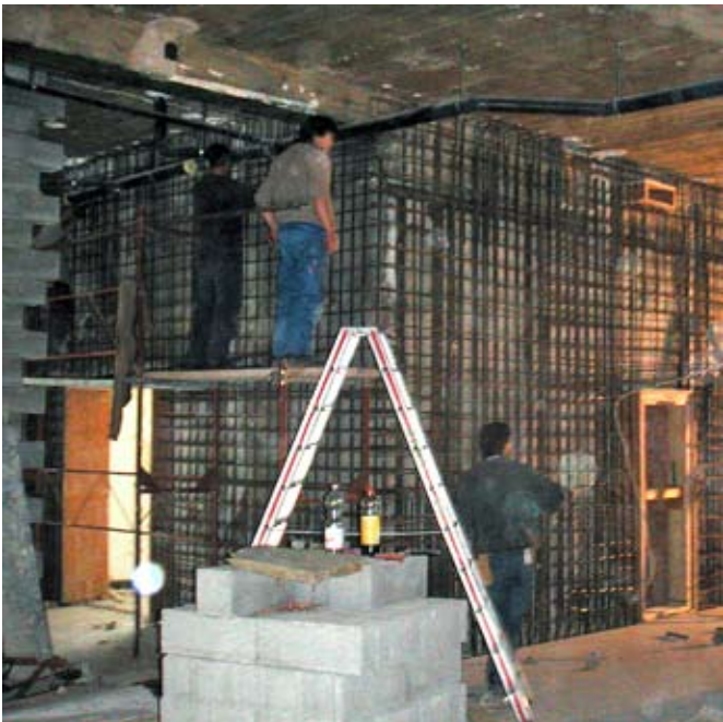
Mise en place de l'armature des nouvelles parois en béton armé au rez-de chaussée.
