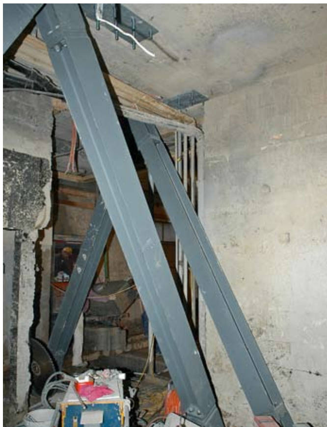
Insertion de nouveaux treillis d'acier en «V» au rez-de-chaussée.
