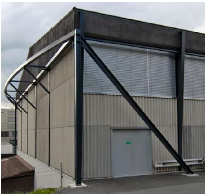
Renforcement sous forme de treillis arqué des façades d'extrémité.
