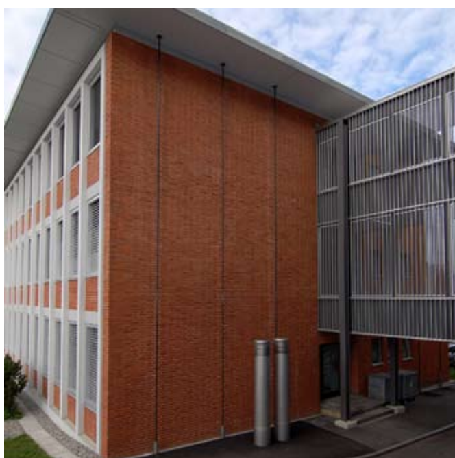
Façade d'extrémité nord, renforcée par des éléments externes verticaux précontraints en fibres de carbone.
