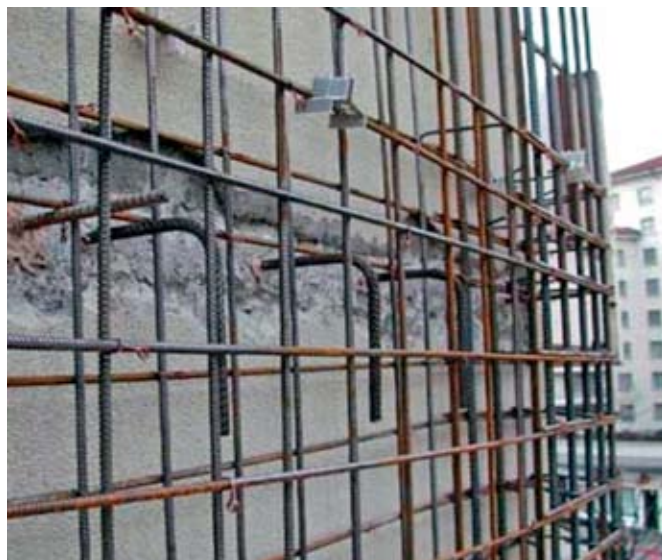
Détail d'armature d'une nouvelle paroi en béton armé avec les armatures de liaison scellées dans les dalles existantes.
