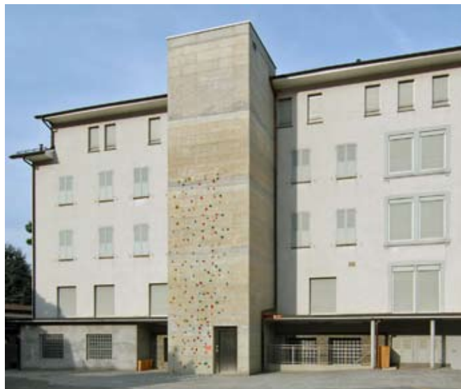
Vue de la façade longitudinale arrière avec nouveau noyau d'ascenseur en béton armé.
