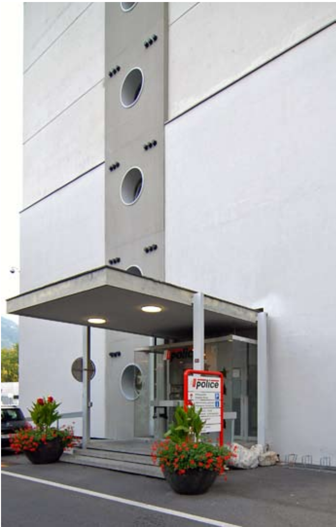
Façade latérale du bâtiment existant, avec les ancrages des câbles précontraints visibles de l’extérieur à la hauteur de chaque dalle d’étage.
