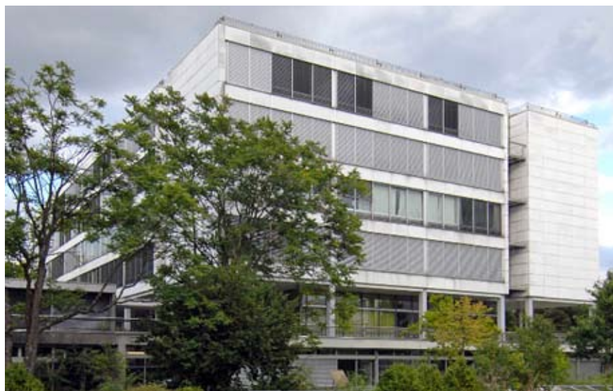
Vue de la façade latérale du bâtiment.
