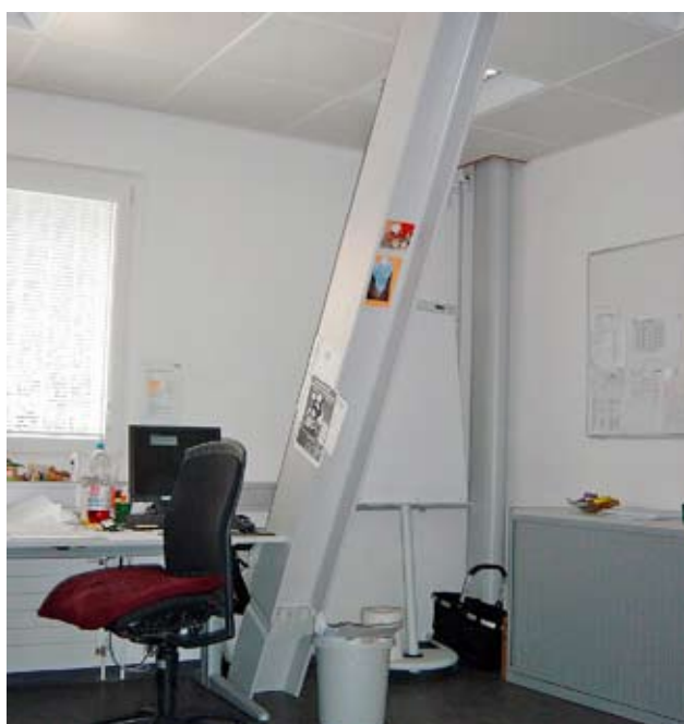
Nouveau treillis d'acier en «V» dans un bureau du rez-de-chaussée.
