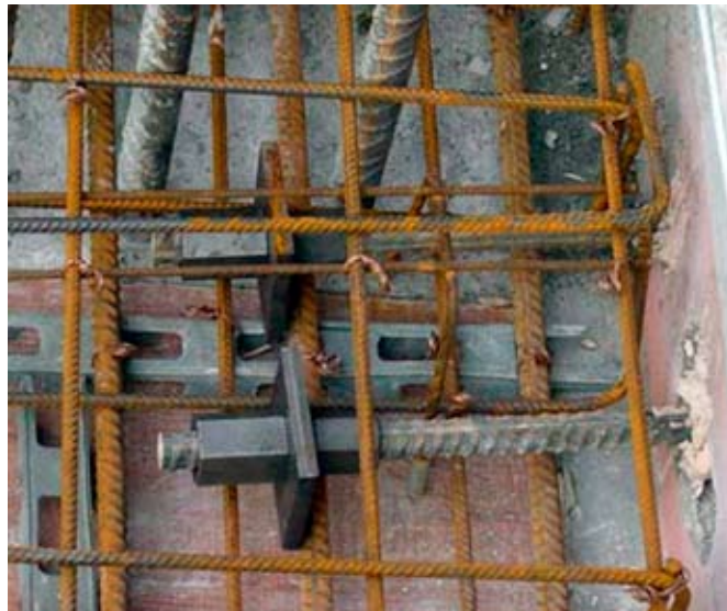
Ancrage du noyau d'ascenseur dans les dalles en béton armé existantes au moyen de barres Swiss-Gewi et d'une armature de répartition collée.
