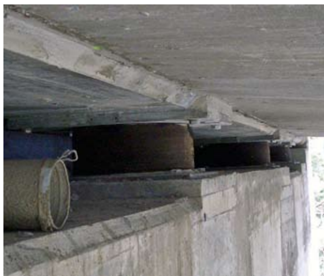
Confortement parasismique par insertion d'appuis sismiques en caoutchouc stratifié à haut pouvoir amortisseur aux culées.
