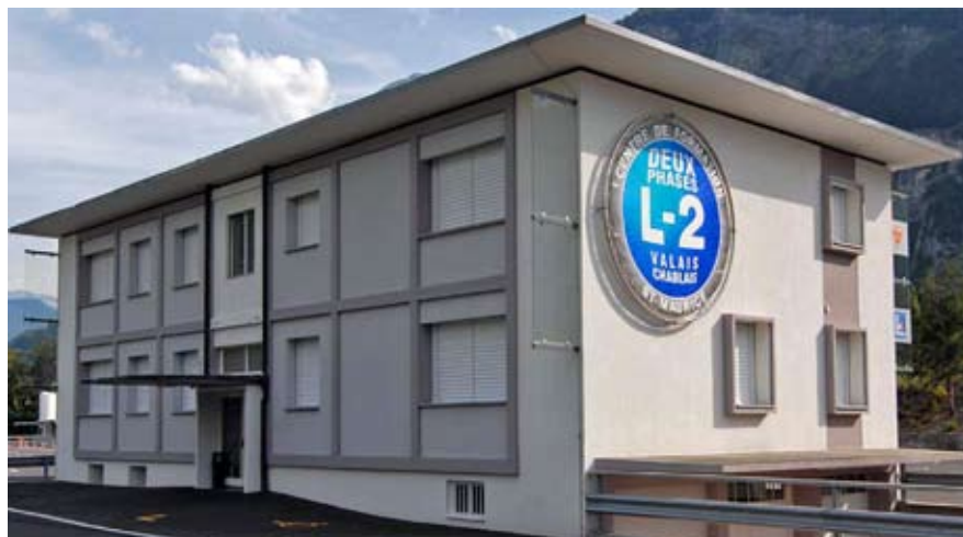
Vue de la façade arrière avec la nouvelle paroi en béton armé au niveau du cadre intermédiaire à droite.
