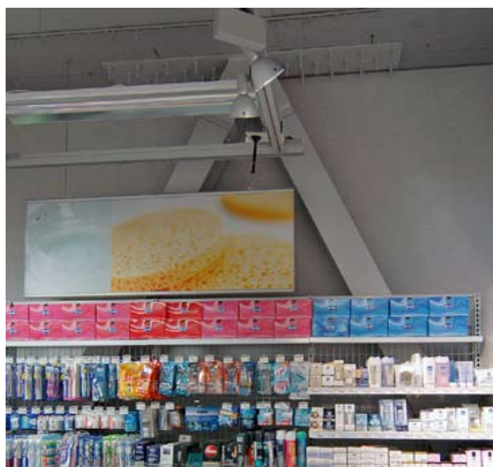
Nouveau treillis d'acier en «V» caché derrière un rayon de vente du rez-de-chaussée.
