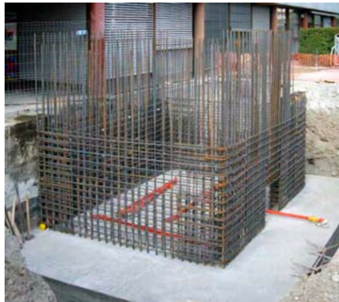
Armature au sous-sol et fondation d'une nouvelle cage d'escalier.
