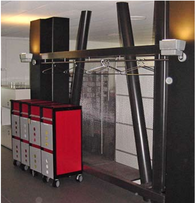
Nouveau cadre en acier avec habillage des colonnes.
