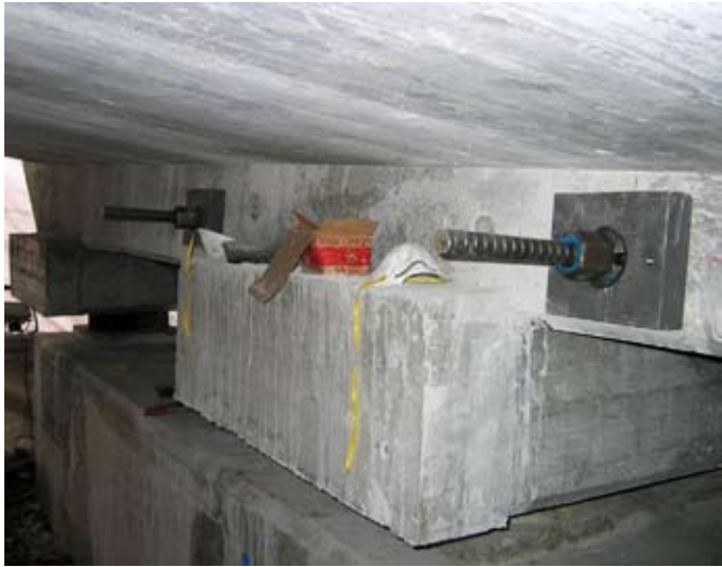
Solidarisation des deux moitiés du pont à la hauteur du joint de dilatation se trouvant initialement au milieu de l'ouvrage.
