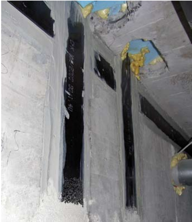
Renforcement des noyaux d’ascenseurs avec des lamelles en fibre de carbone.
