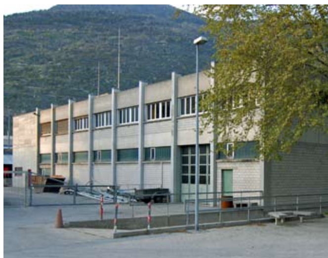
Façade longitudinale arrière du bâtiment du service du feu avec les parois stabilisatrices en béton armé à l'extrémité gauche.
