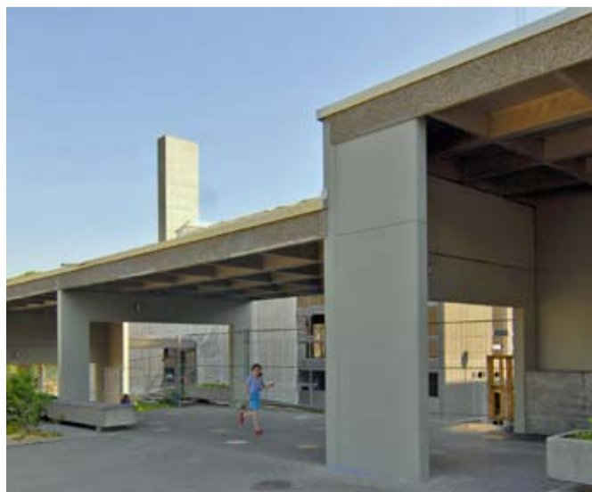
Galerie de liaison confortée longitudinalement par des parois en béton armé.
