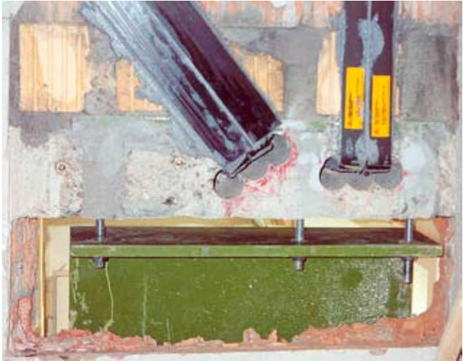
Ancrage des lamelles en fibre de carbone dans les dalles en béton armé à l'aide de cornières résistant au cisaillement.
