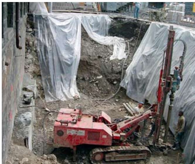
Réalisation de la fondation du nouveau noyau d'ascenseur en béton armé avec des micropieux.
