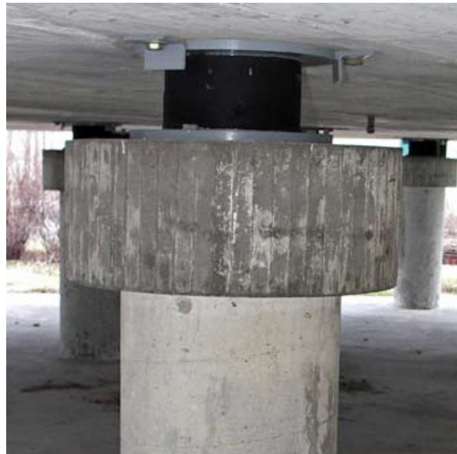
Appui en caoutchouc spécial intégré sous le réservoir de gaz liquide.
