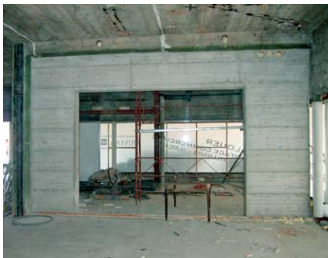
Nouveau cadre en béton armé au rez-de-chaussée.
