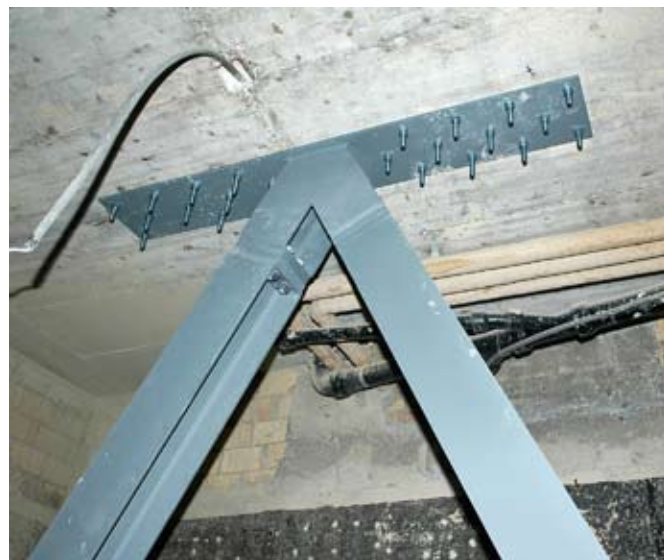
Ancrage d'un nouveau treillis d'acier en «V» dans la dalle du premier étage.
