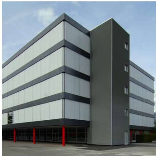
Vue de la nouvelle cage d'escalier côté sud.
