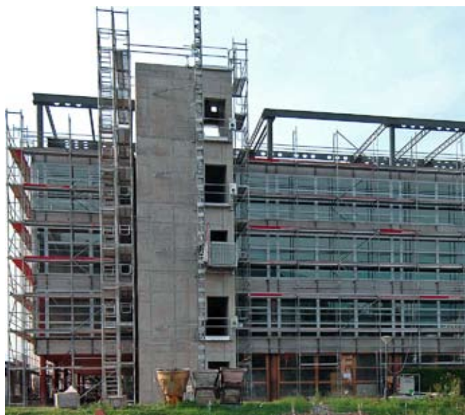
Construction d'une cage d'escalier et rehaussement du bâtiment (côté sud).
