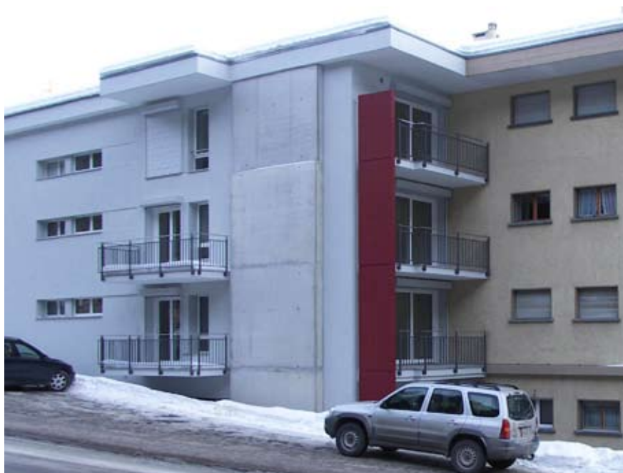
Vue de la façade nord avec les nouvelles parois en béton armé.
