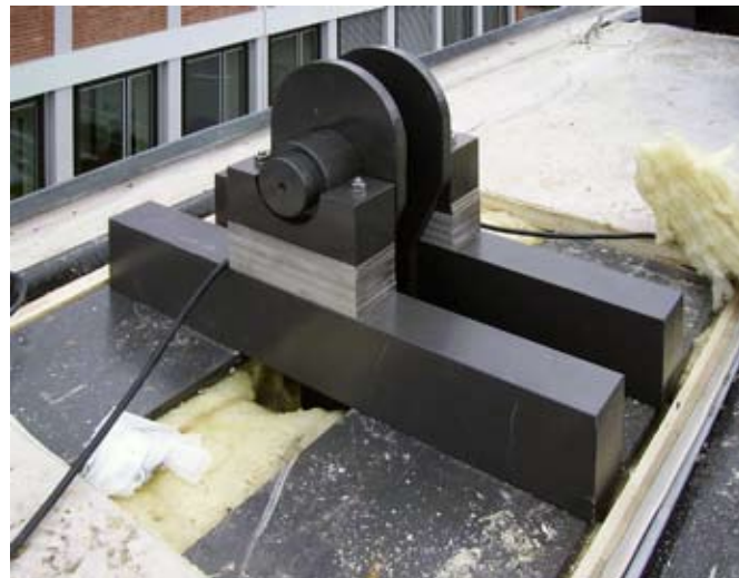
Ancrage supérieur des éléments en fibres de carbone sur le toit, d'où ils sont précontraints.
