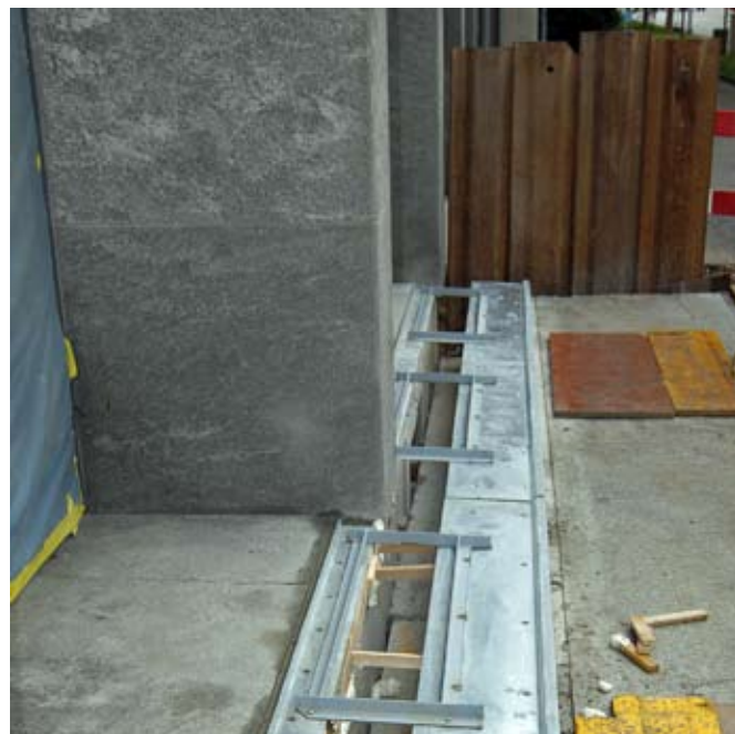
Application d'un joint de dilatation tout autour du bâtiment, afin qu'il puisse osciller librement dans le plan horizontal sur ses nouveaux appuis sismiques.
