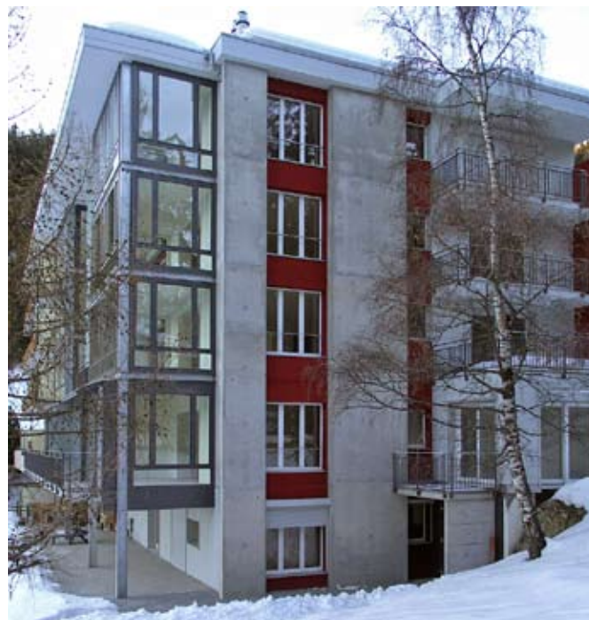
Vue de la façade est avec les nouvelles parois en béton armé.
