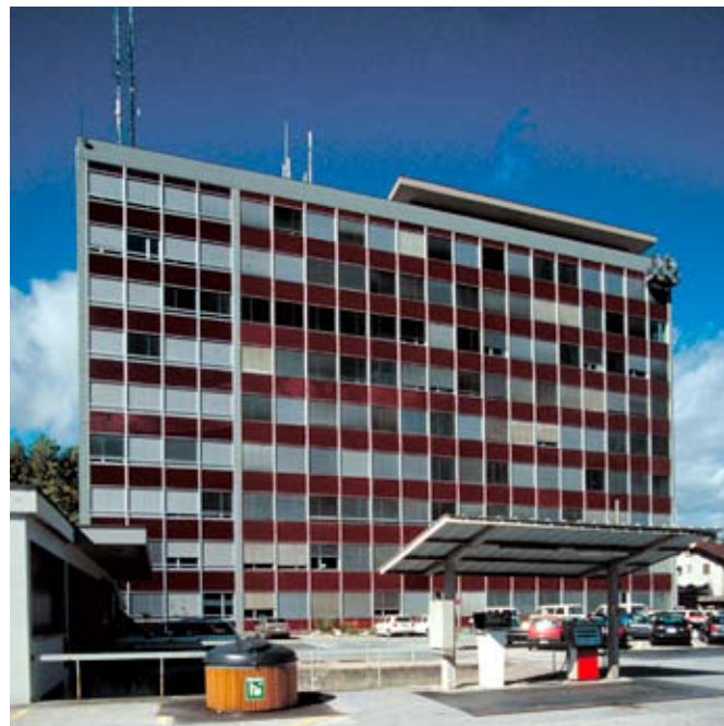
Vue de la façade longitudinale: les quatre premiers rangs de fenêtres correspondent à la nouvelle extension.
