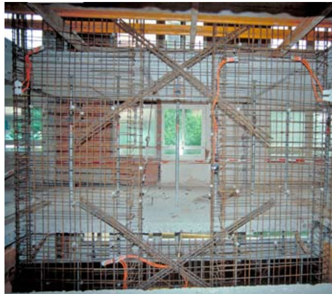
Armature d'une nouvelle paroi couplée en béton armé au rez-de-chaussée, avec des barres diagonales dans les poutres de liaison.
