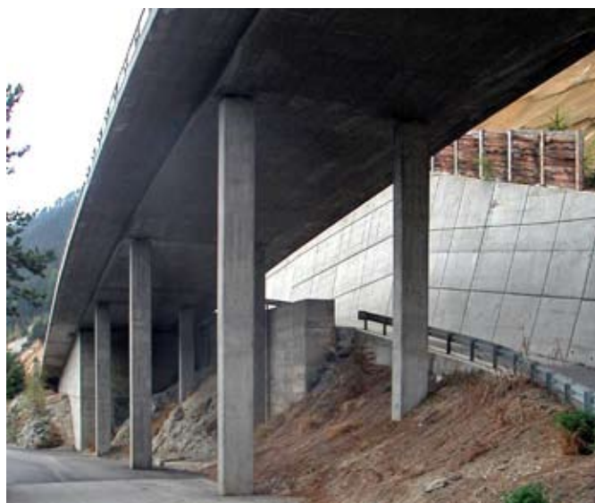
Vue d'une partie du pont avec des piliers hauts et élancés.
