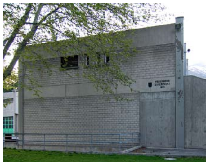
Paroi en maçonnerie non armée située au sud du bâtiment qui a été renforcée avec des lamelles verticales en fibres de carbone.
