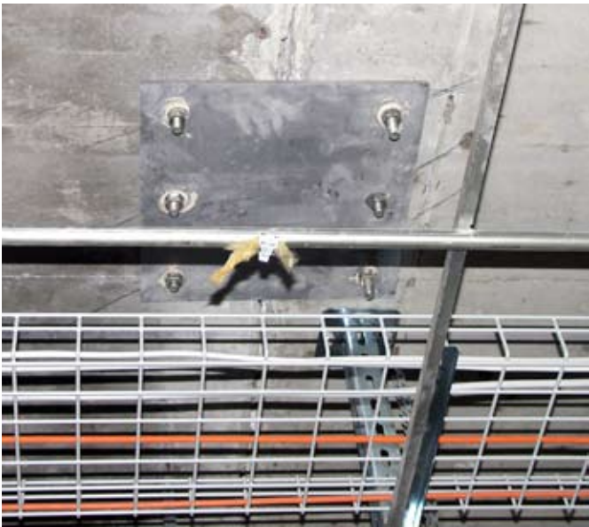
Clavage du joint dans les dalles d’étage par des plaques en acier disposées sur les deux faces des dalles.
