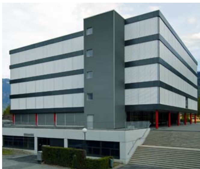
Vue de la nouvelle cage d'escalier côté nord.
