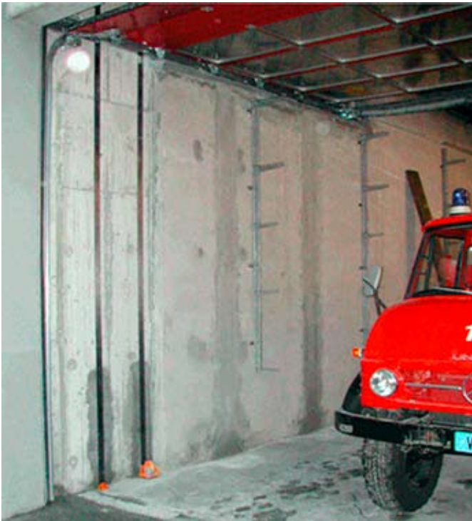
Deux lamelles précontraintes en fibres de carbone appliquées sur la face interne de la paroi pignon (Truffer et al., 2004).
