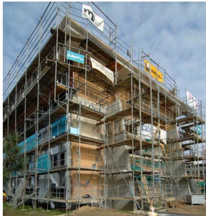
Les deux nouvelles parois triangulaires en béton armé en construction du côté sud.
