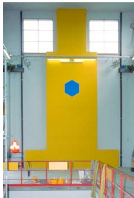
Nouvelle paroi porteuse en béton armé sur la face interne de la façade est de la halle de montage.
