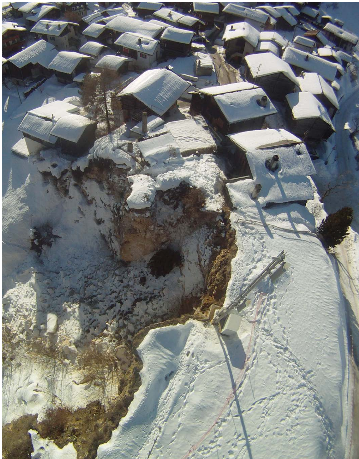
Fig. 11 La doline de Nax (VS) (cf. p. 4). Une interdiction d'utilisation a été prononcée pour la maison à droite et les petits bâtiments sur le bord. Leurs propriétaires ont été indemnisés. La propriété des constructions destinées à la démolition a été transférée à la commune. Photo : BEG, Bureau d'Études Géologiques SA.
