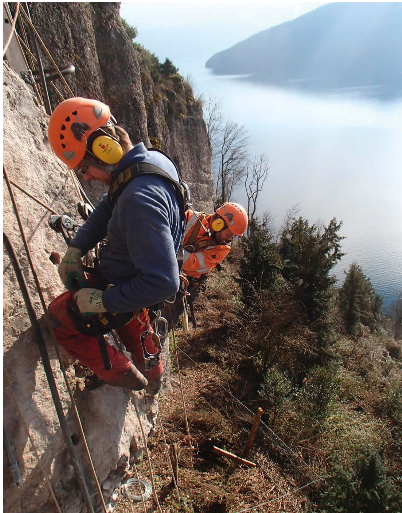
Fig.2 Enlèvement de roches à titre préventif pour protéger les bâtiments et infrastructures situés en contrebas, à Weggis (LU). De telles mesures ne sont toutefois pas toujours efficaces, c'est pourquoi les biens immobiliers du site voisin de « Horlauri » ont dû être démolis. Photo : Louis Ingenieurgeologie.
