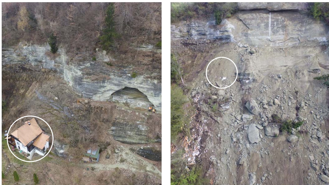
Fig. 10 Photo de gauche : Maison menacée par un éboulement de rochers qui a été évacuée dans la vallée du Gottéron (FR) (cf. p. 4). Des discussions sur la suite de la procédure étaient prévues avec l'assurance immobilière cantonale. Photo de droite : Le 25 avril 2016, des blocs de roches ont détruit la maison abandonnée. La question d'un dédommagement anticipé a ainsi été réglée. Photos : Geotest SA, commune de Tavel, service des forêts et de la faune de l'État de Fribourg.
